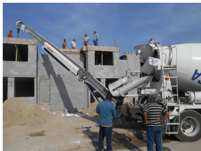
Se empieza a colar por la parte más lejos.
