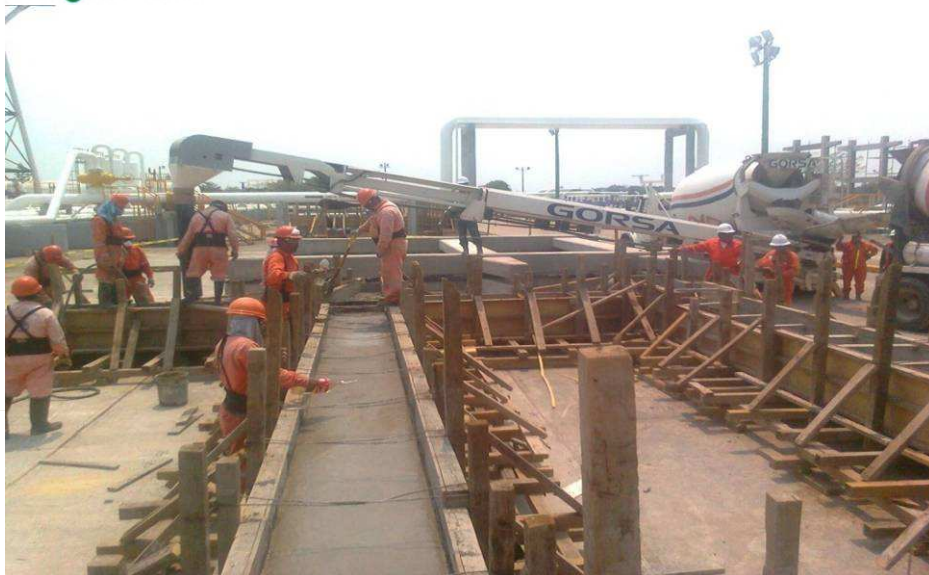
Colado del canal
