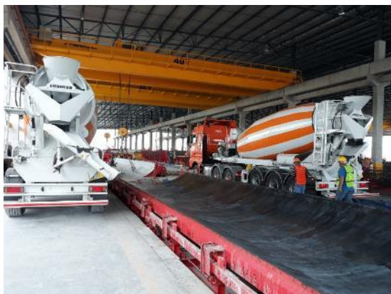
Colado con una hormigonera cada lado
