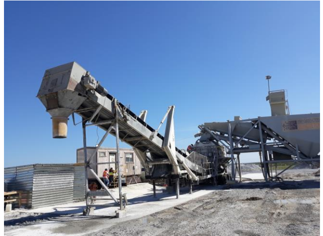
2019 se consiguió 70 km de obra y el MTS n°1 fue trasladada cerca Nuevo Laredo
